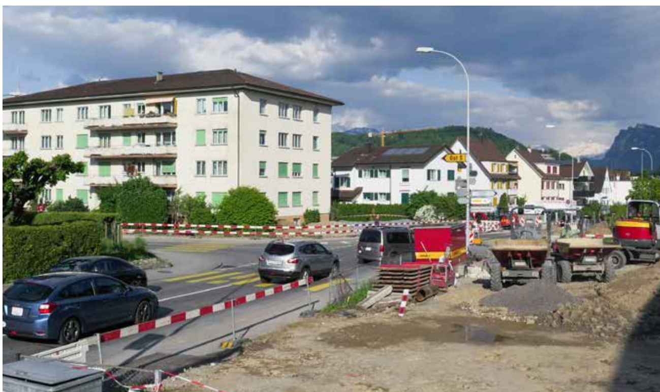
An der Kreuzung Horwerstrasse/Lauerzweg/Arsenalstrasse entsteht bis Ende Jahr ein Kreisel. Bereits jetzt wird intensiv gebaut.
