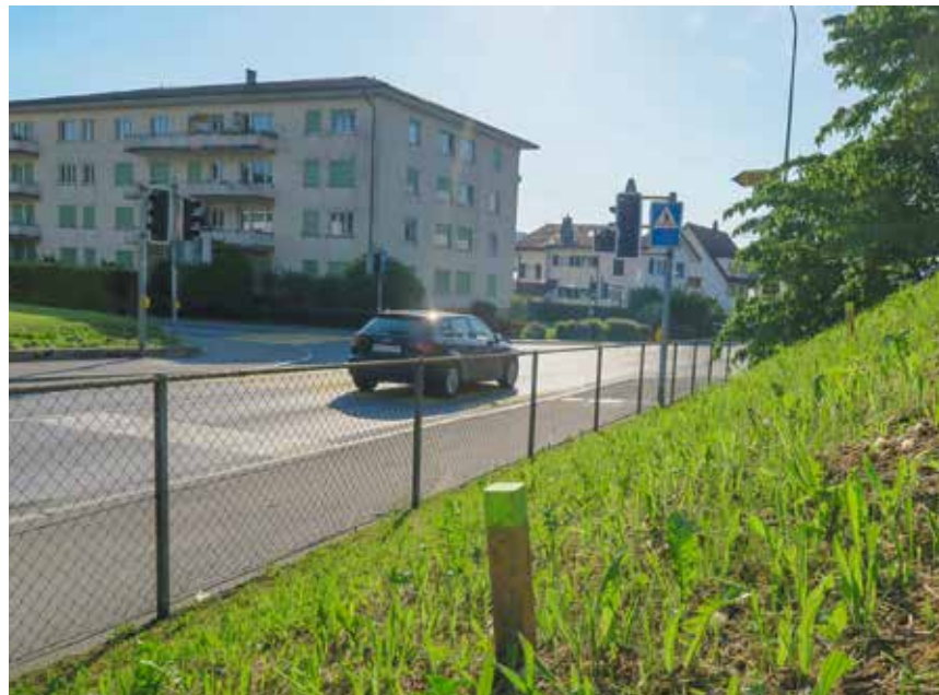
Hier entsteht bis Ende 2019 der neue Kreisel: Kreuzung Horwerstrasse mit Arsenalstrasse/Lauerzweg.
